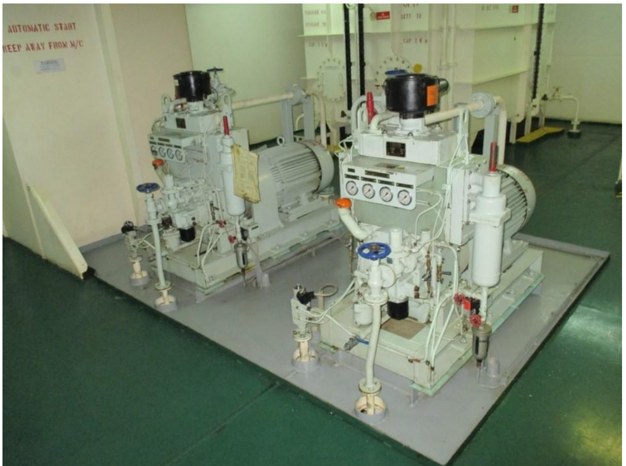
Рисунок 1.1 - Компресори системи пускового повітря
